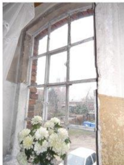
Fot. 2: Stolarka okienna, typ O-01. Widok wewnętrzny.
