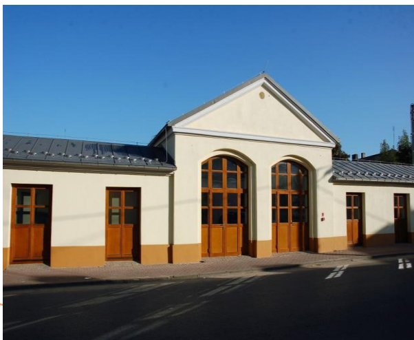
Po zakończeniu prac
