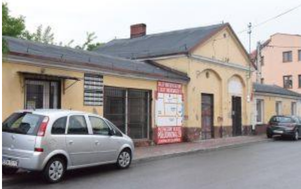
Przed i w trakcie prac
